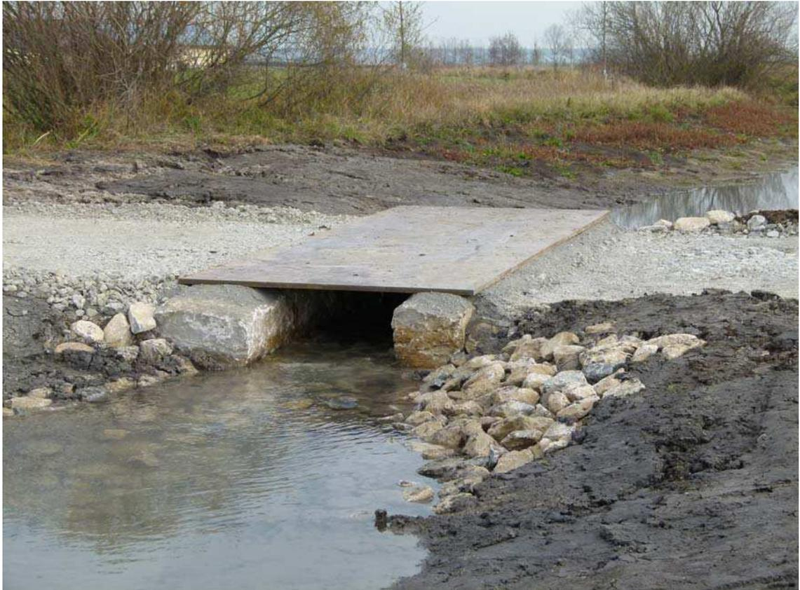
Abbildung 5: Prinzip Behelfsüberfahrt für Schoppenbachverlegung
